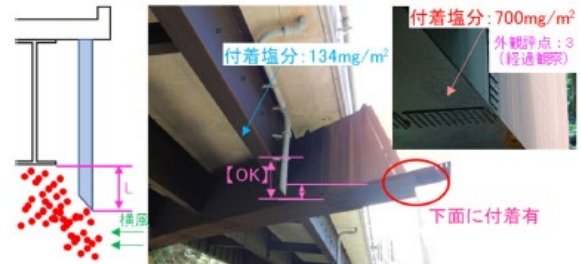
図-6 D橋の排水管状況
