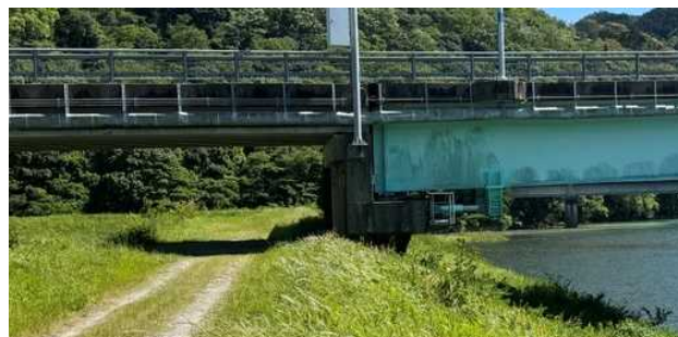
写真-1 維持管理が困難な堤体内の橋脚(ピアアバット)の管内事例(国道56号 新宿毛大橋)
