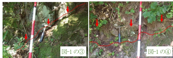
(a) 節理上方岩盤に移動傾向 (b) 露頭上面付近のハラミ出し 写真-3 終点側無処理区間法面の状況
