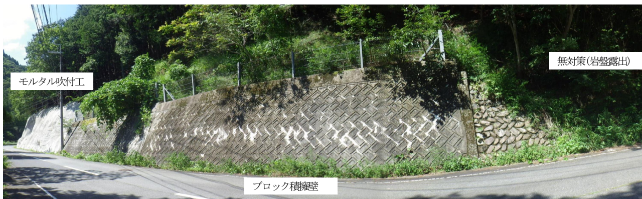
写真-1 対象地全景(左:起点側, 右:終点側)
