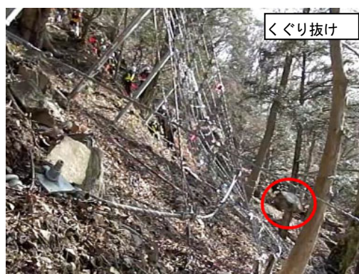
写真-5 落石減勢工衝突後 (落石 No. C)
