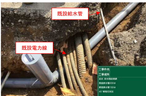
図4 掘削による埋設管確認状況
