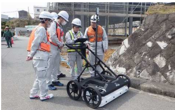
図 3 レーダ探査状況
