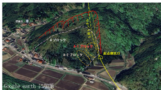
図6 当該トンネル周辺の地すべり
