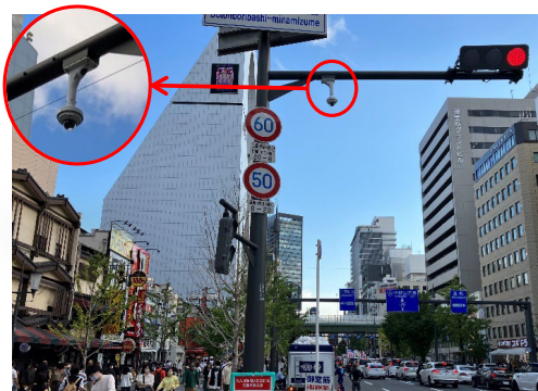
図3 AI カメラの設置状況
