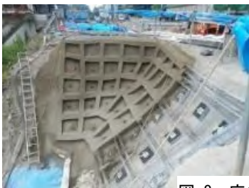
図-8 応急対策工(施工時)
