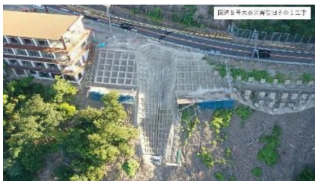
図-14 対策工全景
