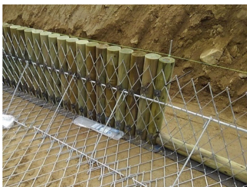
写真-3 間伐材の取付け状況
