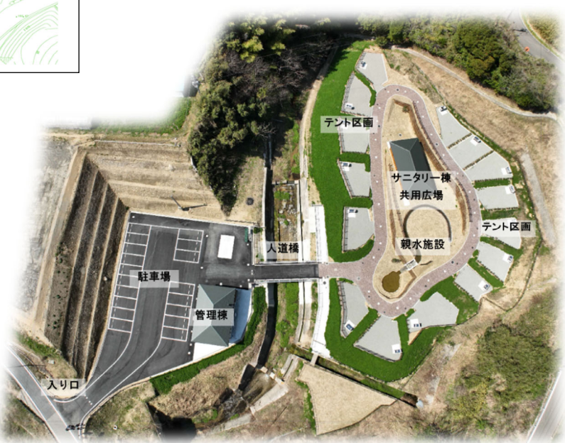
図-4 完成時の空中写真 (淡路市提供資料に追記)
