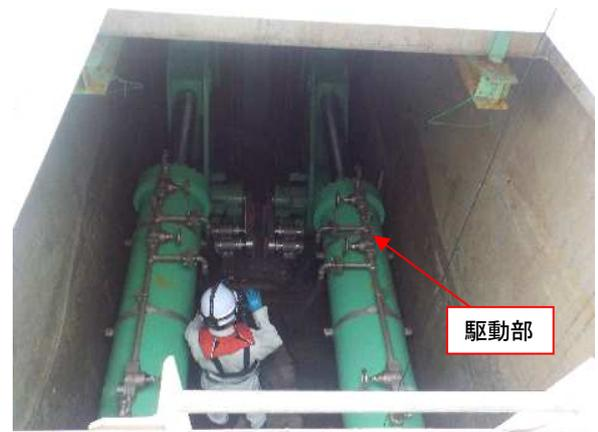
図-5 中空断面堰柱内部の現地写真
