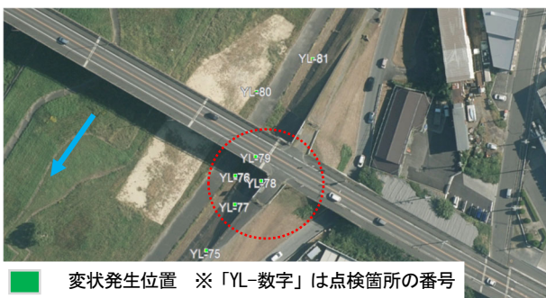
図-11 三次元河川管内図 (X川) 橋梁付近の様子
