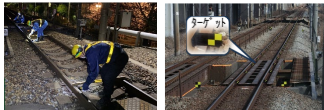
図-2 検測とレールウォッチャー計測状況
