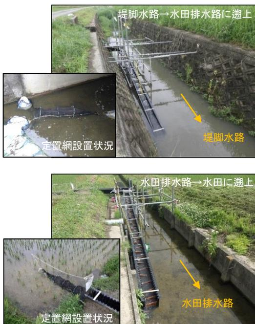
図1 魚道の設置状況(上：簡易魚道、下：水田魚道)
