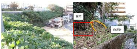
写真. 現地状況
