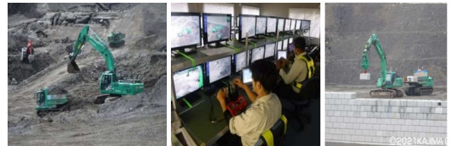
▲ 無人化施工状況
