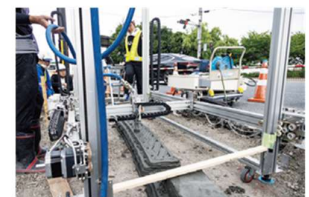
イメージ（3Dプリンタによる構造物施工）
