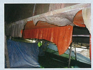
塗膜の除去状況
