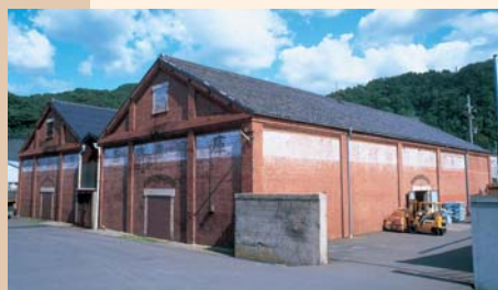
敦賀赤レンガ倉庫
