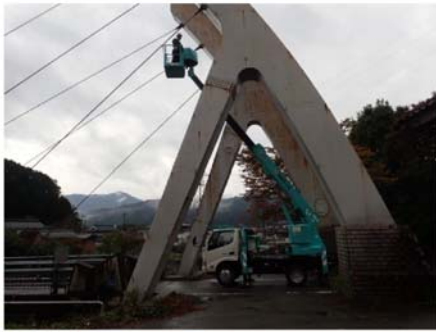
図-2 高所作業車による点検
