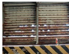
写真-2 パネル腐食状況
