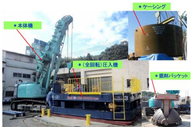
図-3 小型立坑圧入工法（ケコム工法）の施工機械
