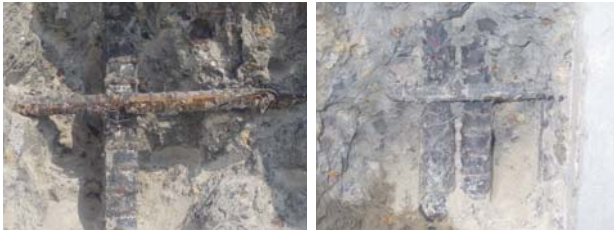
写真-2 ハツリ調査(鉄筋劣化状況)
