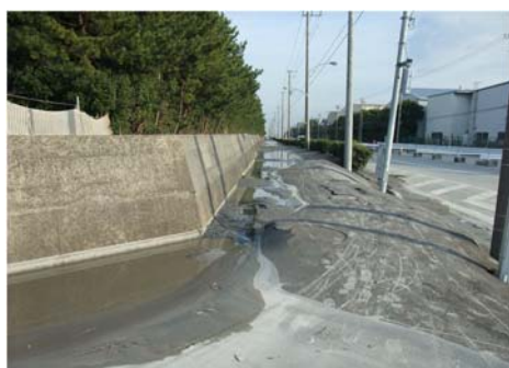
写真－1 幹線道路歩道の突き上げ被害 (千葉県浦安市)
