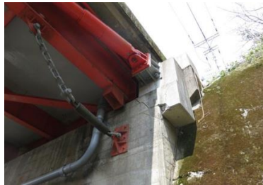
写真-1 ジョイント部の損傷状況
