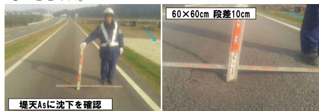
写真-1 陥没発生箇所(左:遠景, 右:近景)
