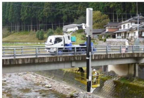
図-1 橋梁点検車による点検
