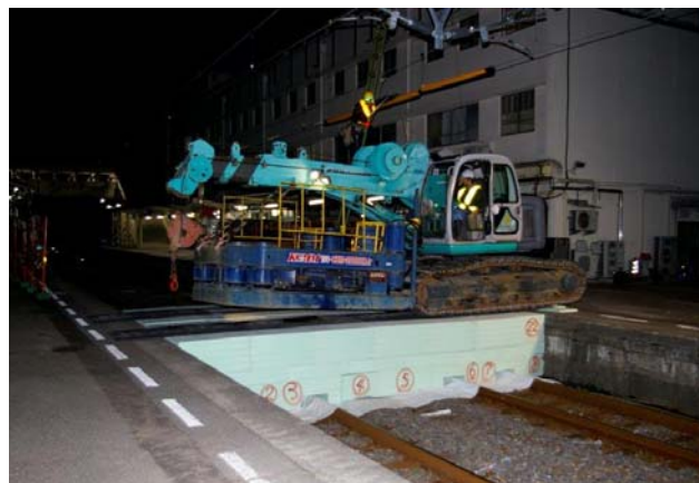
図-4 ホーム間工事前仮設路の設置とケコム工法施工機械の移動状況
