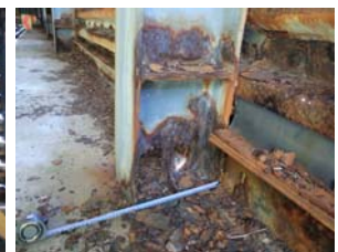
写真-3 支柱腐食状況
