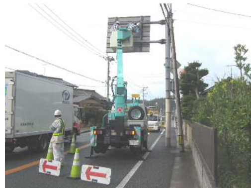
写真ー1 高所作業車による近接目視
