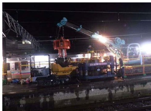
図-5 島式ホームでの掘削状況
